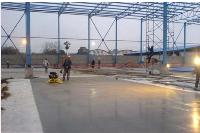
Durante el vaciado de concreto con fibras
