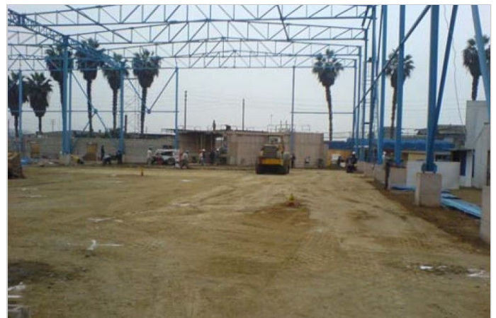
Antes del vaciado de concreto
