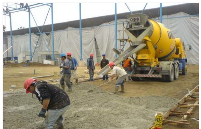
Durante el vaciado de concreto con fibras
