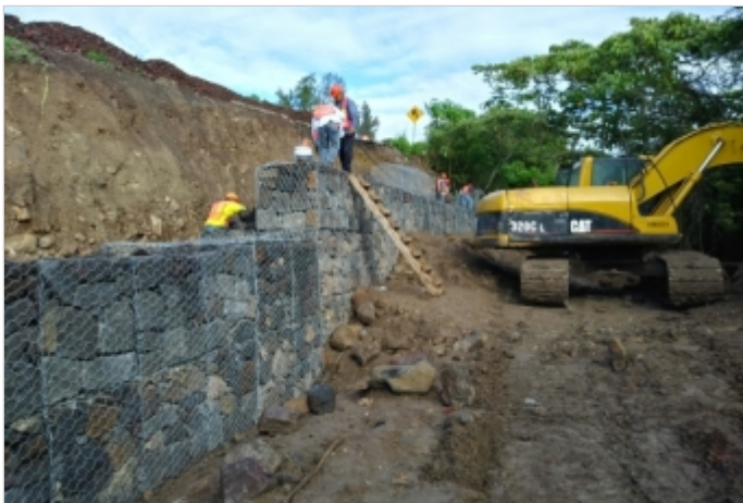
Durante la Obra
