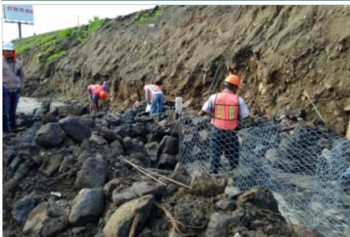
Durante la Obra
