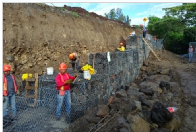
Durante la Obra
