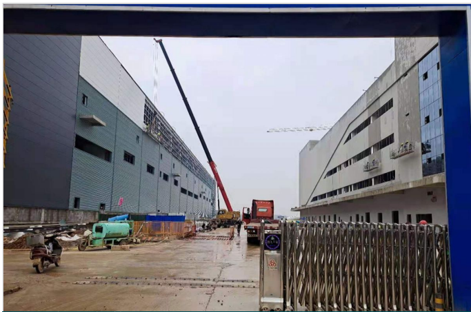
图3-项目现场外观
