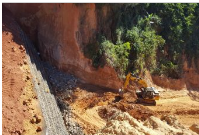
Durante a obra
