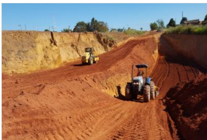
Durante a obra
