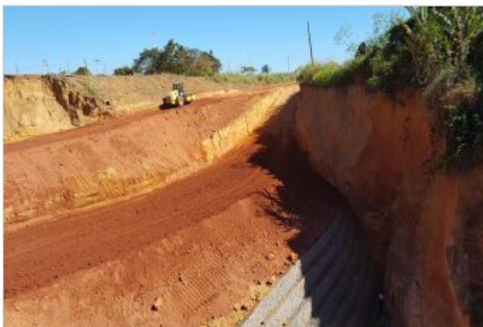
Durante a obra
