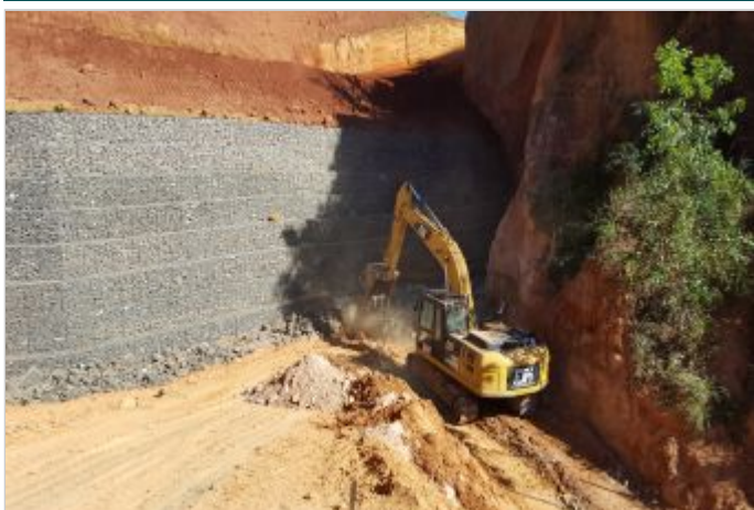
Durante a obra
