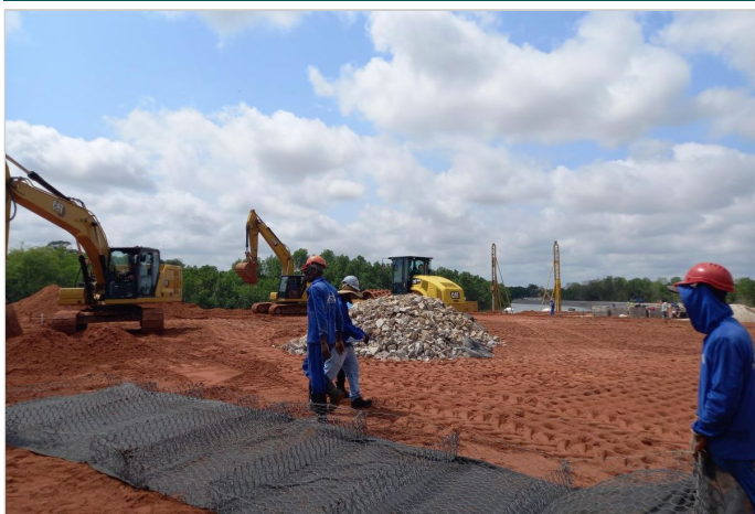
Durante a obra
