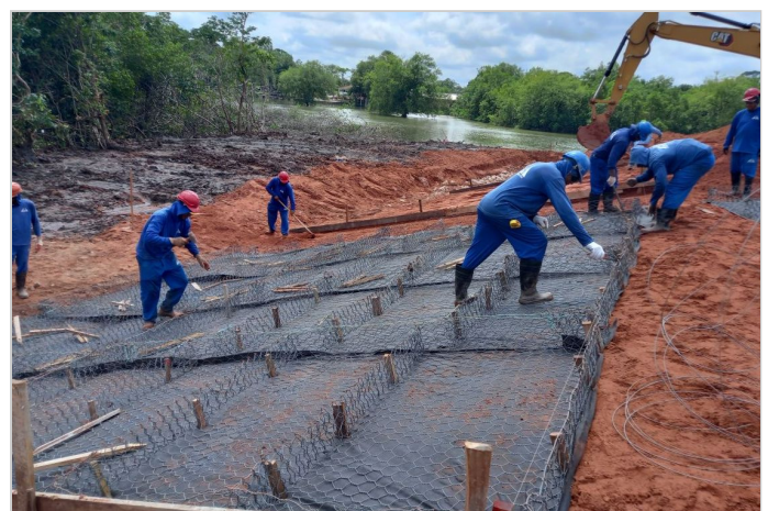
Durante a obra
