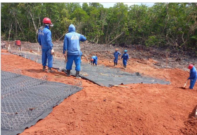
Durante a obra
