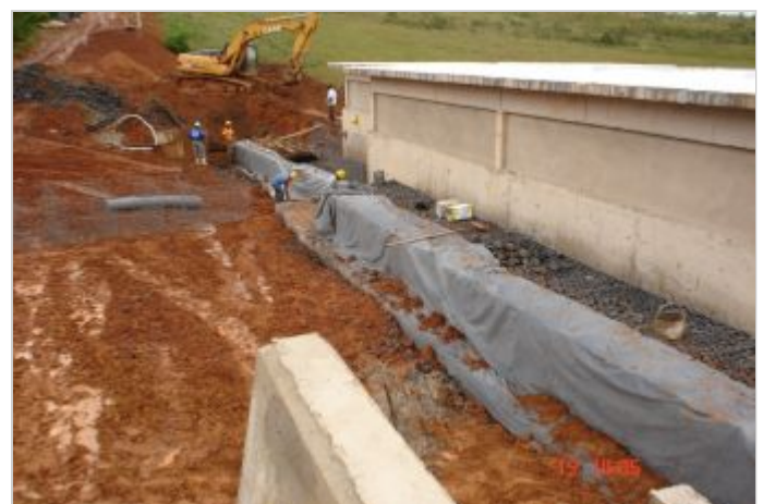
Durante la Obra
