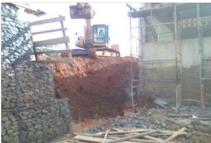
Durante la Obra
