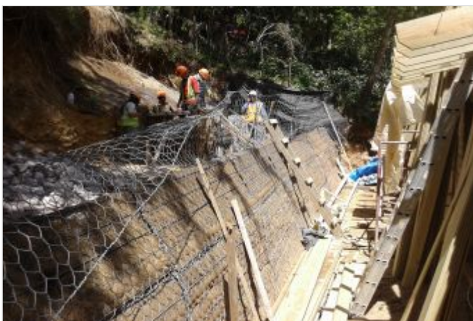
Durante la Obra
