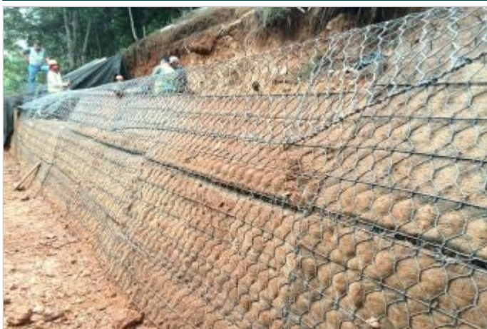
Durante la Obra
