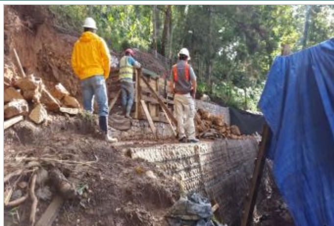
Durante la Obra
