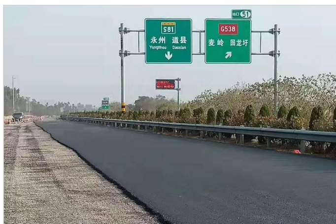
沥青面层摊铺
