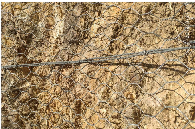
ΠΛΕΥΡΙΚΗ ΣΥΝΔΕΣΗ ΠΛΕΓΜΑΤΩΝ ΜΕ HR-LINKS
