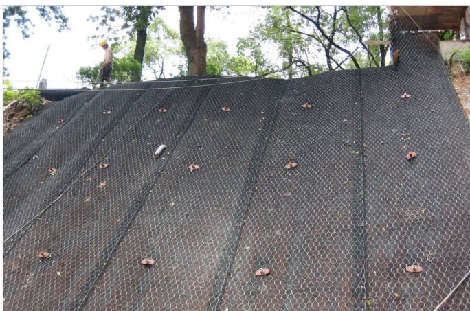
加筋麦克垫结合锚钉铺设
