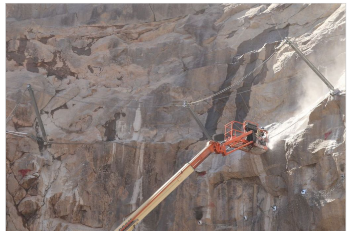
Durante a obra
