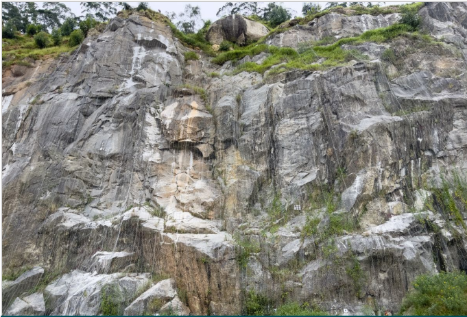
Durante a obra
