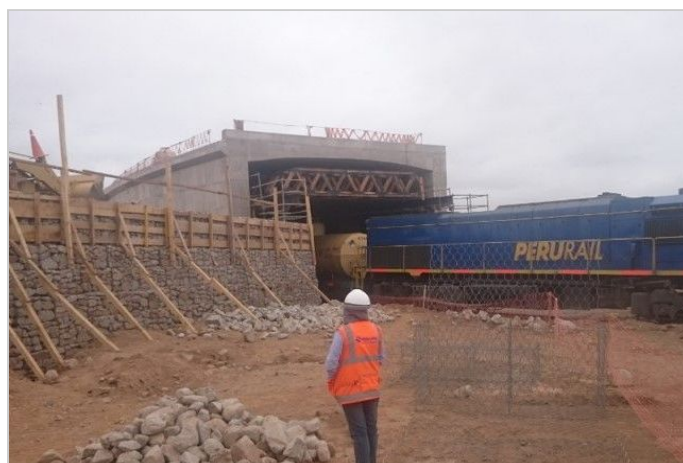
Durante la Obra
