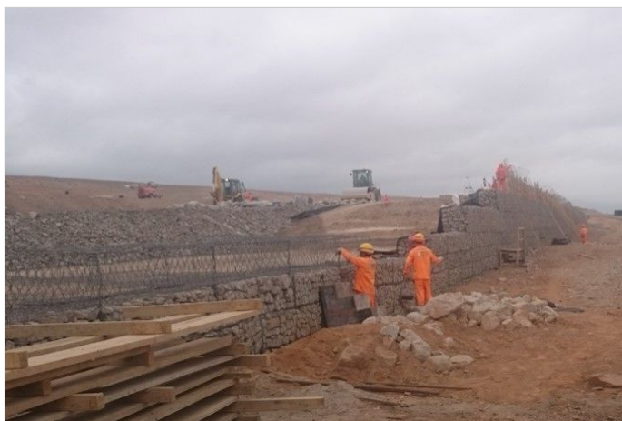
Durante la Obra
