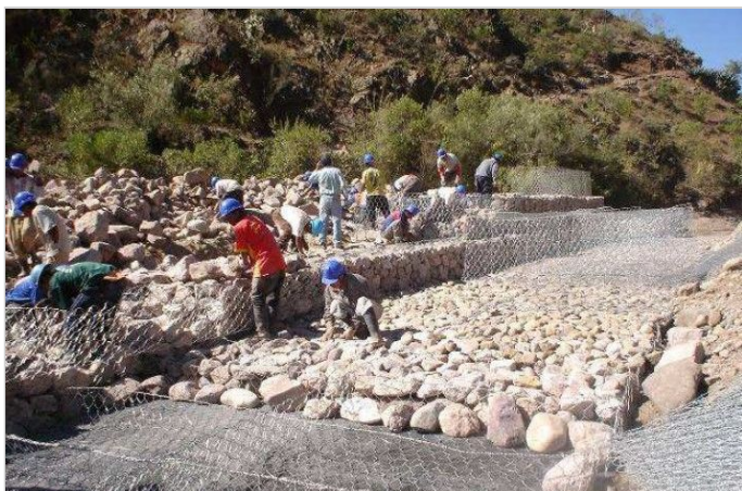
Durante la obra
