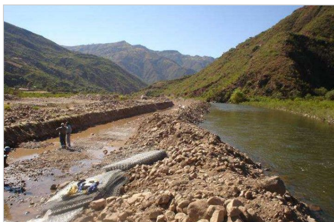
Durante la obra
