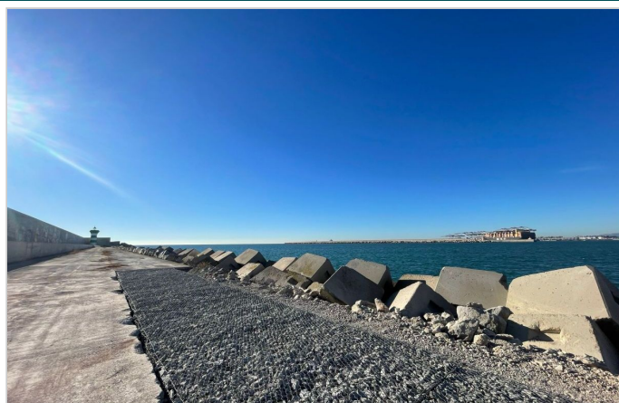
Colchones Reno Plus instalados
