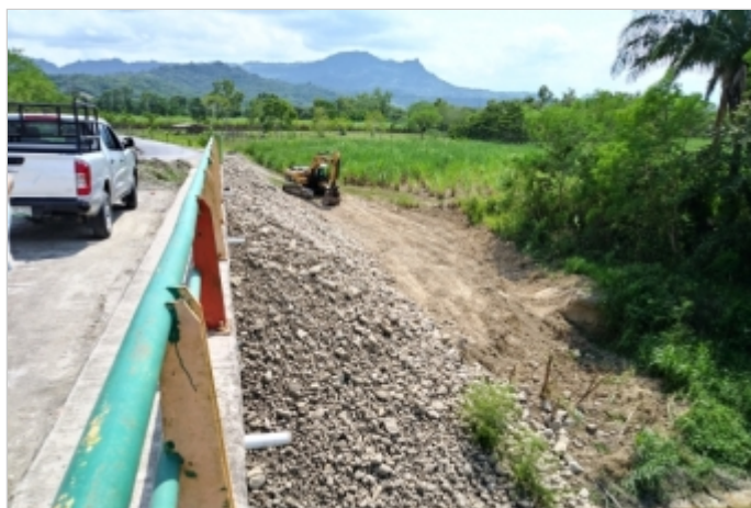
Durante la Obra
