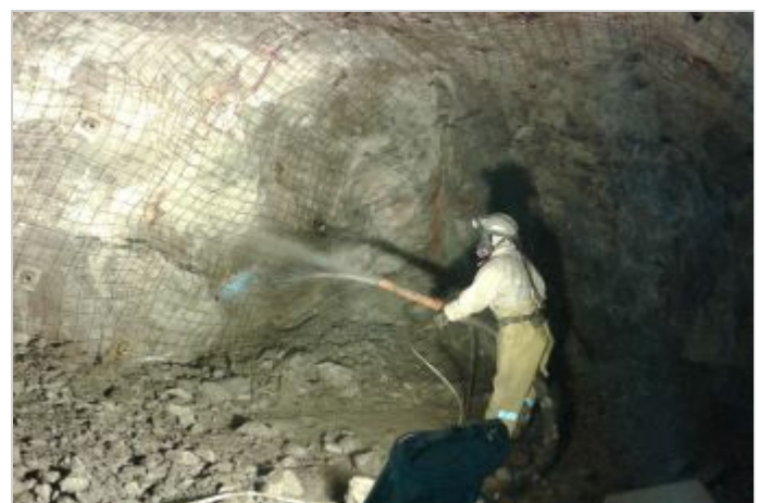
Durante a obra
