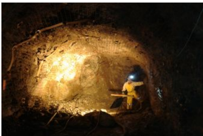
Durante a obra
