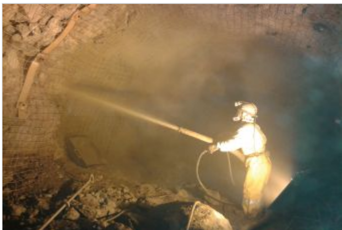
Durante a obra
