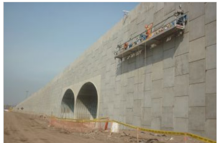
Durante a obra
