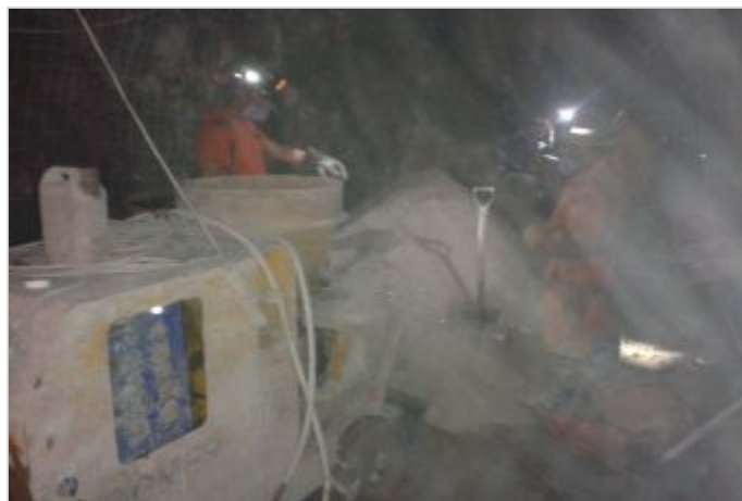
Durante a obra
