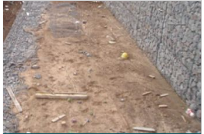
Durante a obra
