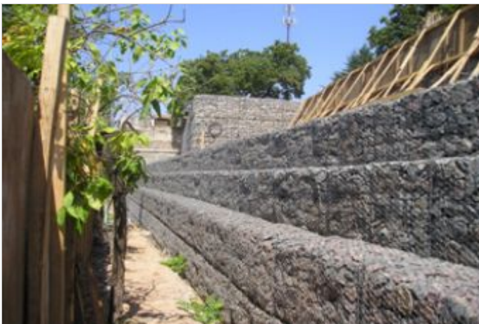
Durante a obra
