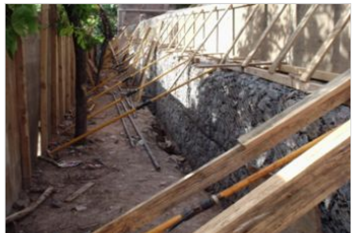
Durante a obra
