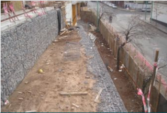
Durante a obra
