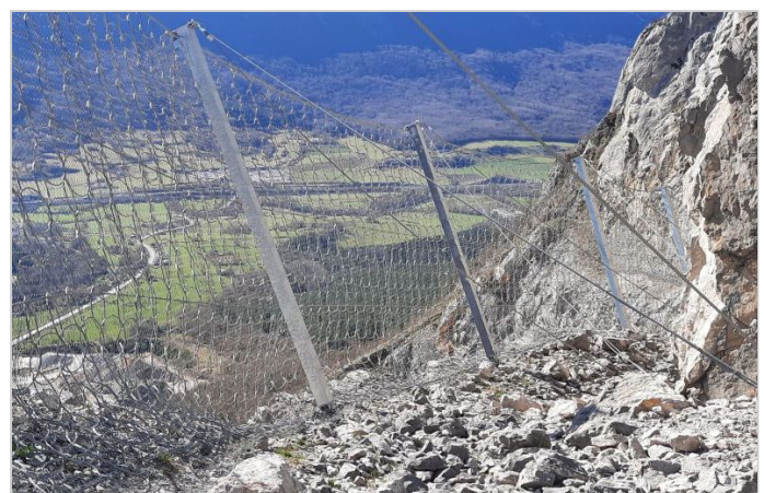
RB 3000-Vista desde monte
