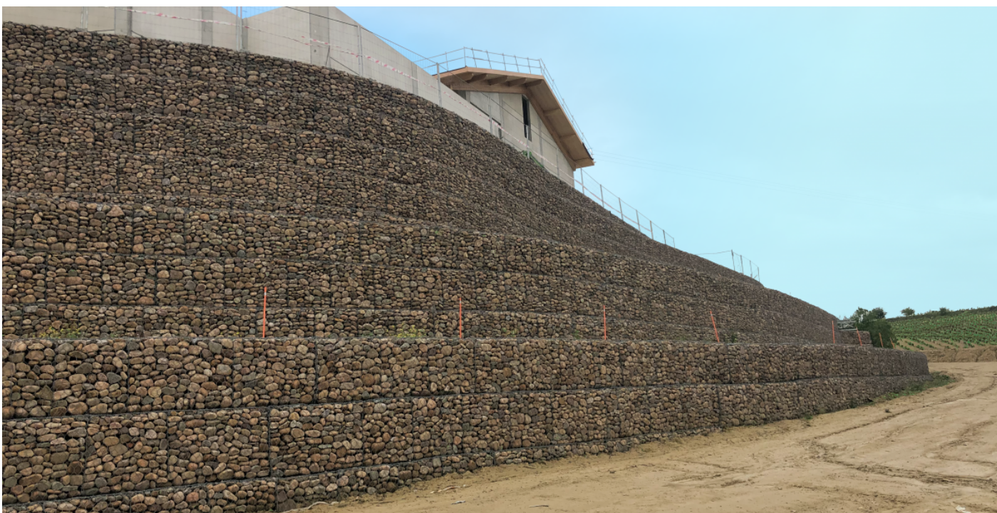
Vista general muro de gaviones al final de los trabajos
