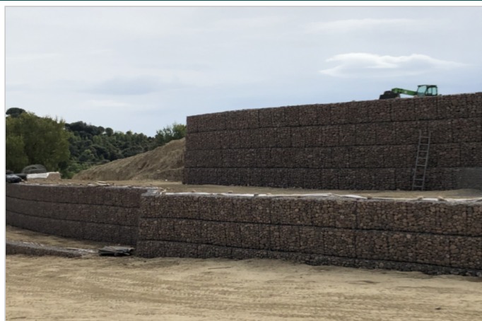
Vista frontal del muro de gaviones durante los trabajos
