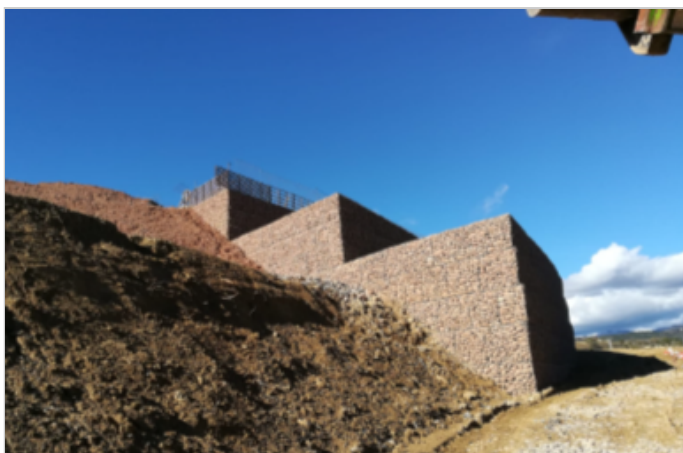
Vista lateral muro de gaviones durante los trabajos
