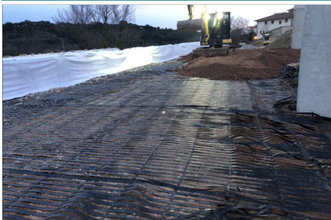
Instalación geomalla Paragrid
