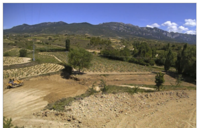
Vista general al inicio de los trabajos
