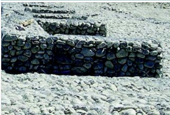
Durante la Obra
