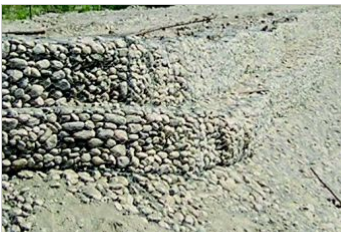
Durante la Obra
