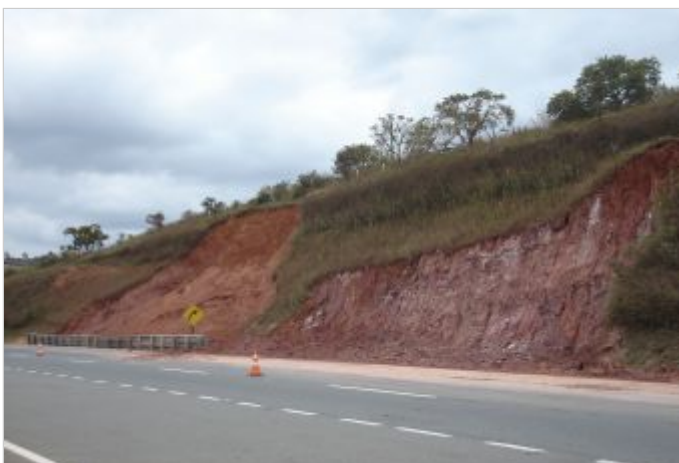
Durante a obra
