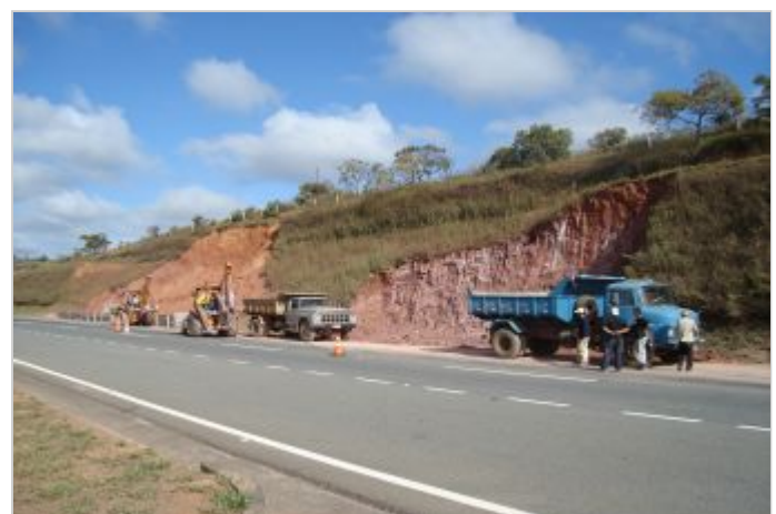
Durante a obra
