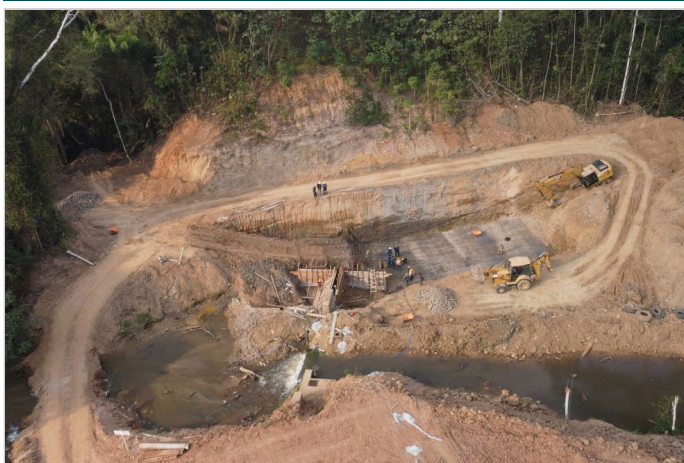
Durante la Obra
