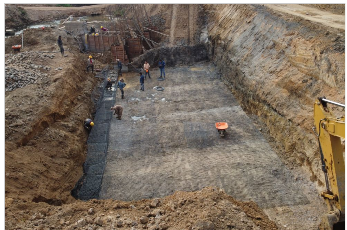
Durante la Obra
