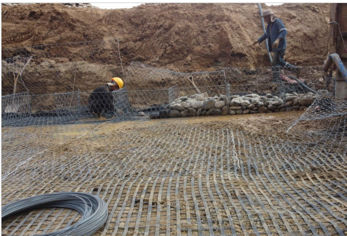
Durante la Obra
