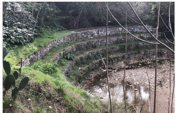
ΠΡΑΝΗ ΡΕΜΑΤΟΣ ΜΕ ΣΥΡΜΑΤΟΚΙΒΩΤΙΑ ΣΕ ΣΚΑΛΟΠΑΤΙΑ
