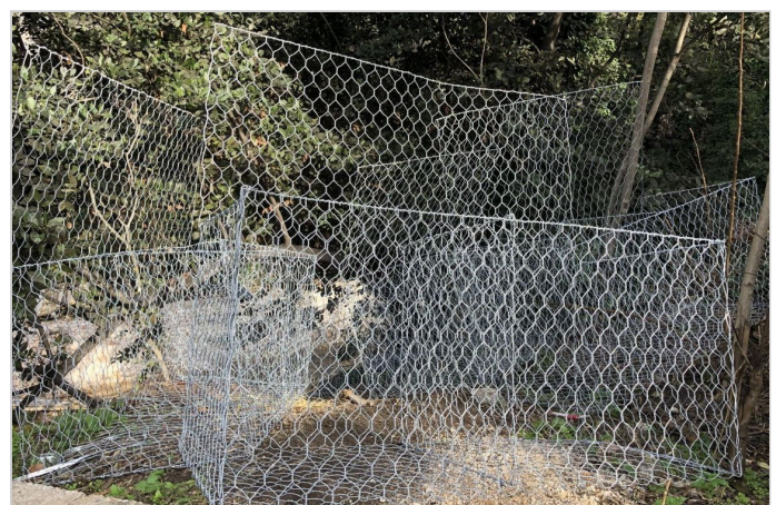
ΠΡΟΚΑΤΑΣΚΕΥΑΣΜΕΝΑ ΣΥΡΜΑΤΟΚΙΒΩΤΙΑ ΠΡΙΣ ΤΟ ΓΕΜΙΣΜΑ ΤΟΥΣ
