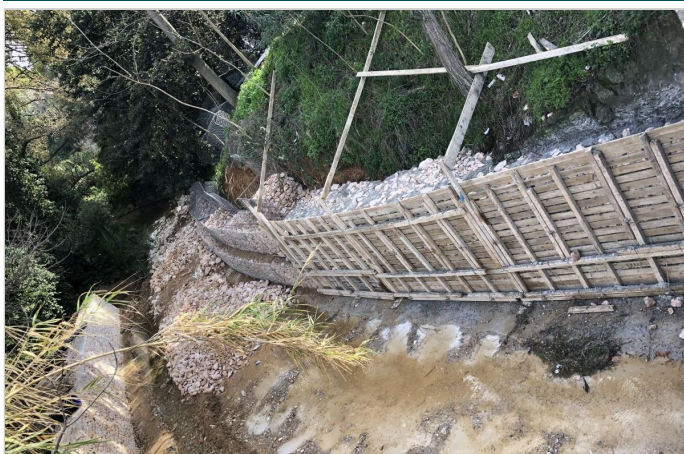
ΕΡΓΑΣΙΕΣ ΑΠΟΚΑΤΑΣΤΑΣΗΣ ΣΥΡΜΑΤΟΚΙΒΩΤΙΩΝ
