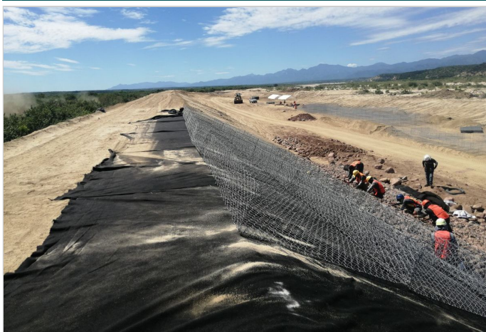
Durante la Obra
