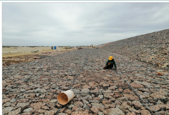
Durante la Obra
