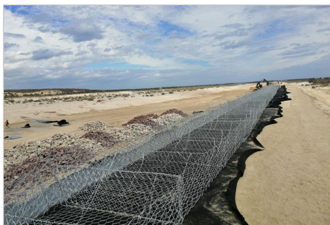
Durante la Obra
