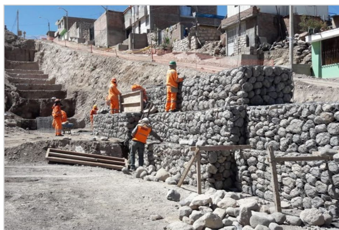
Durante la Obra
