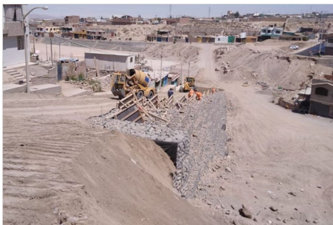
Durante la Obra
