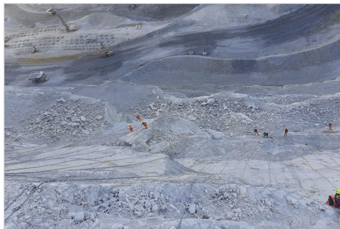
Durante la Obra
