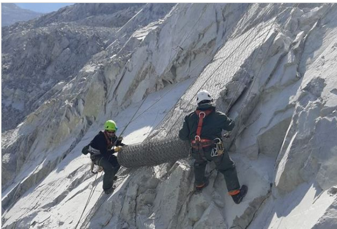
Durante la Obra
