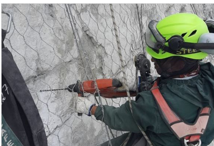
Durante la Obra
