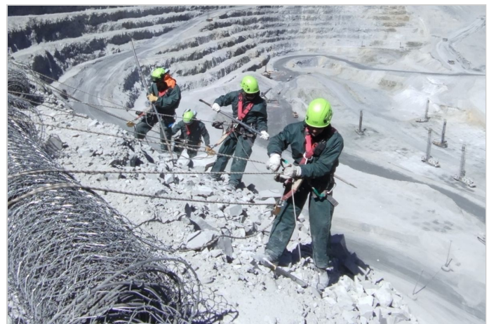
Durante la Obra
