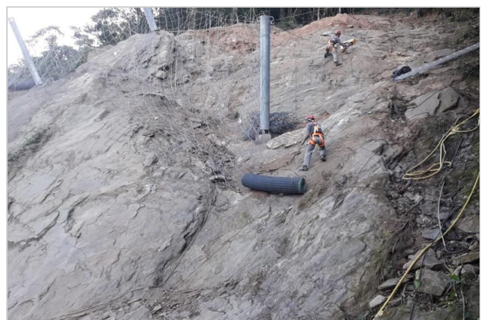
Durante a obra
