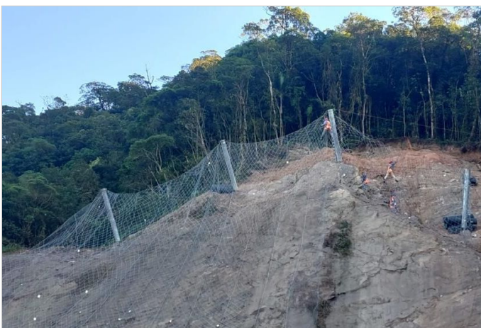
Durante a obra
