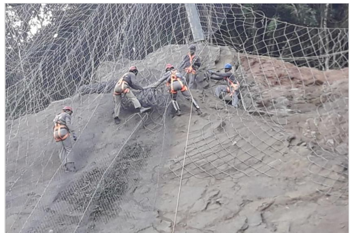
Durante a obra
