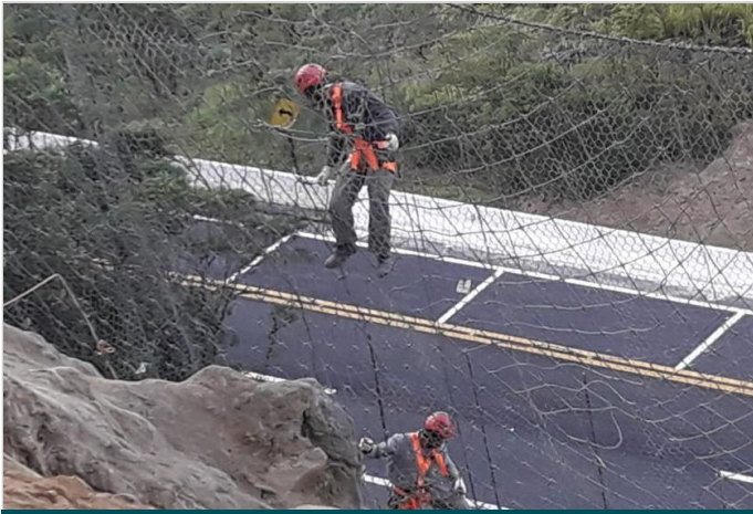
Durante a obra
