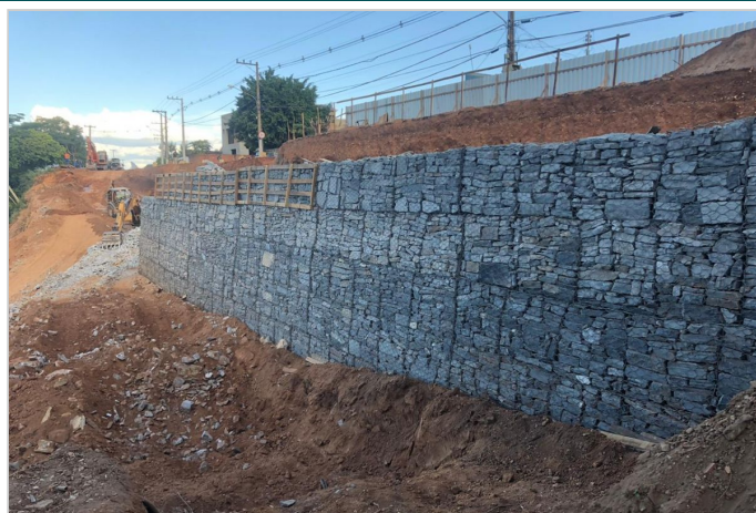
Durante la Obra
