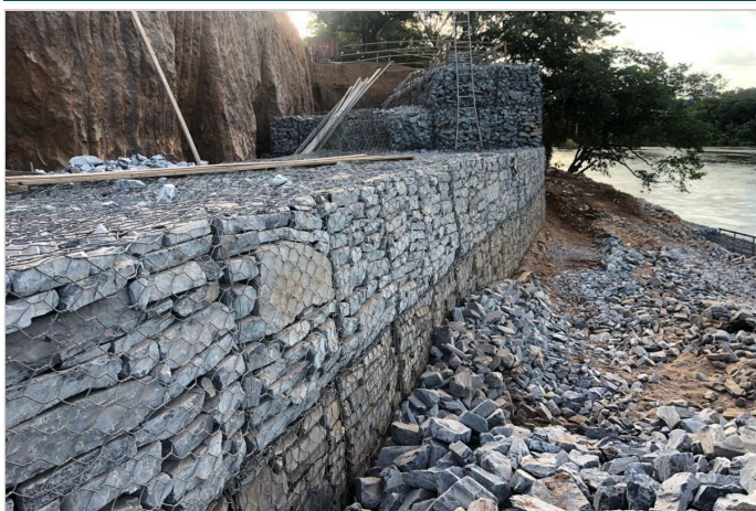
Durante la Obra
