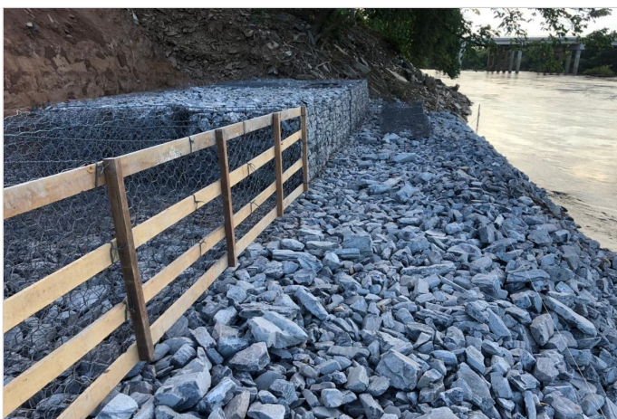
Durante la Obra
