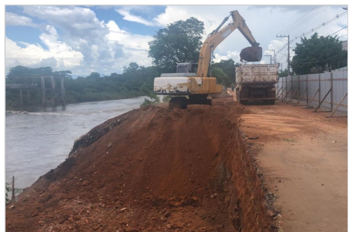
Durante la Obra
