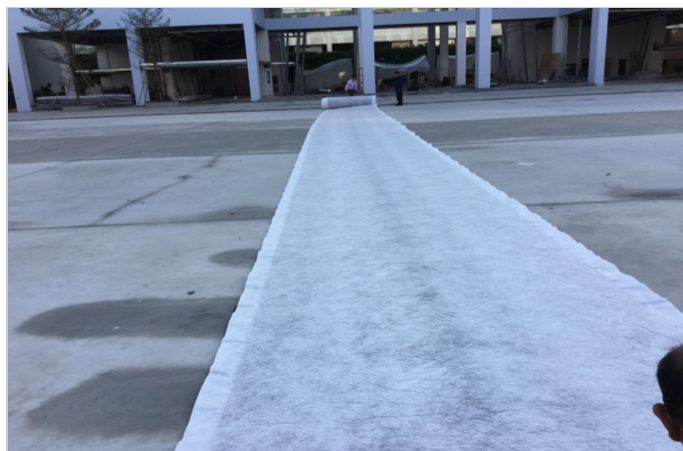
麦克排水垫成卷进行施工铺设
