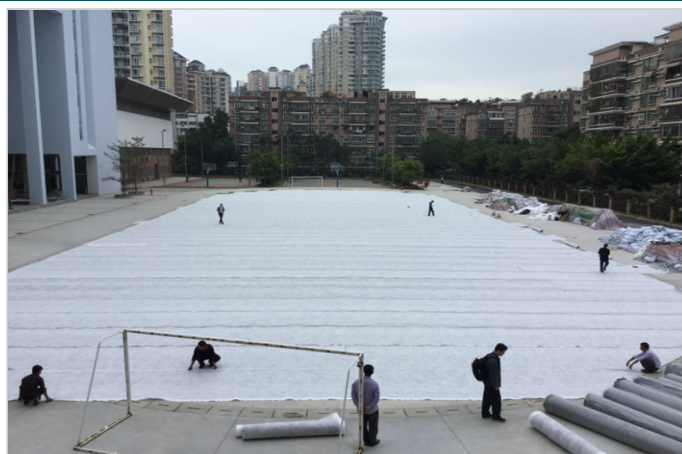
排水垫铺设完工
