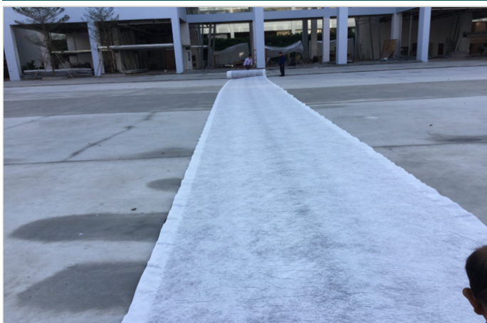
麦克排水垫成卷进行施工铺设
