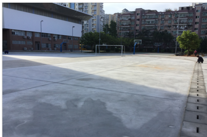
在施工好的混凝土基础上进行放样
