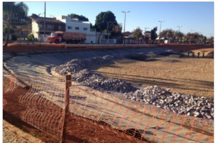
Durante a obra
