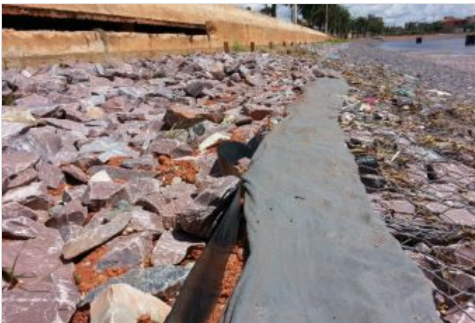
Durante a obra
