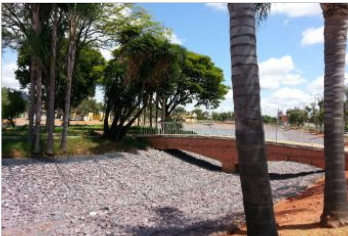
Durante a obra
