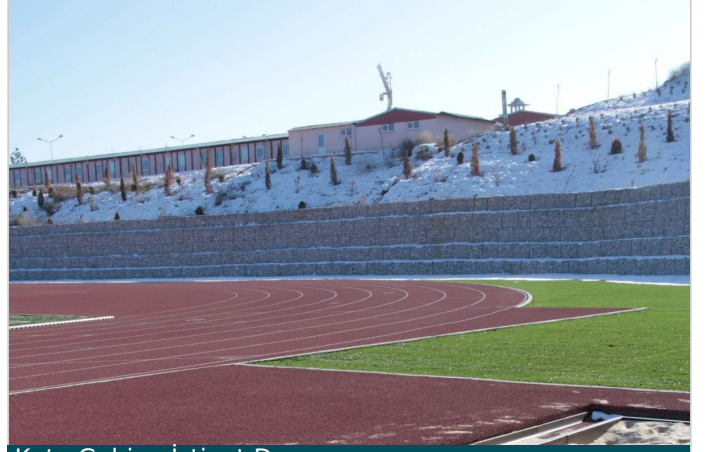
Kutu Gabion İstinat Duvarı
