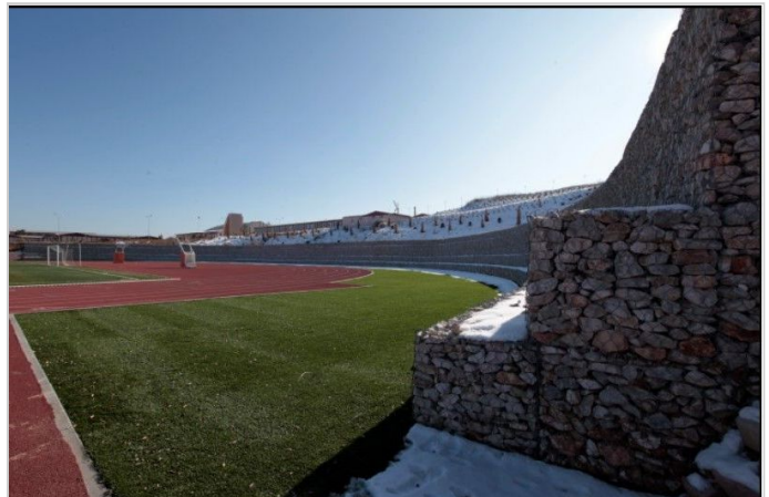
Kutu Gabion İstinat Duvarı
