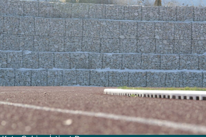
Kutu Gabion İstinat Duvarı
