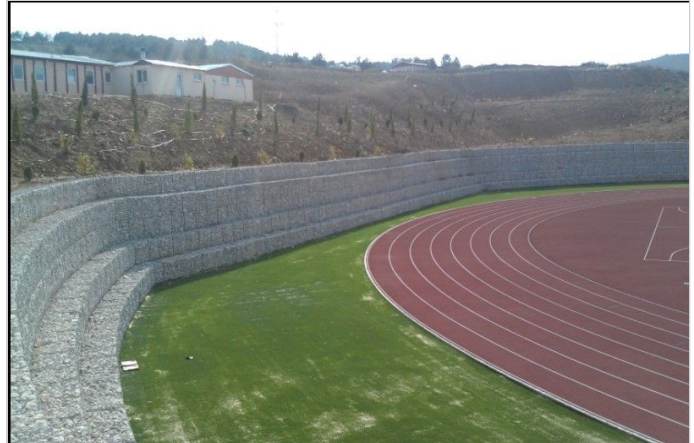
Kutu Gabion İstinat Duvarı
