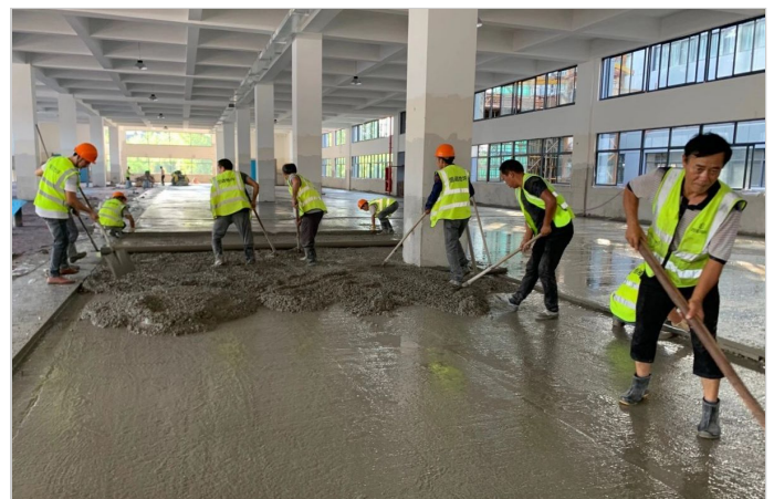
图2-钢纤维混凝土现场浇筑
