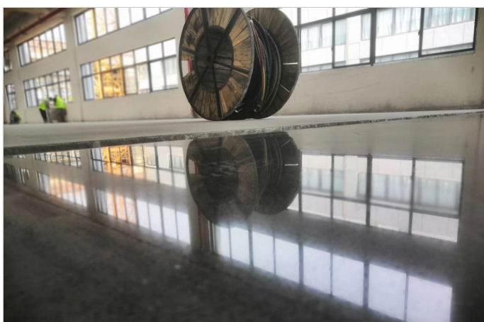
图5-固化剂施工完成效果
