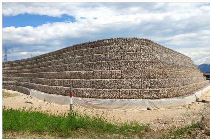
ΚΑΤΑ ΤΗ ΔΙΑΡΚΕΙΑ ΤΗΣ ΤΟΠΟΘΕΤΗΣΗΣ
