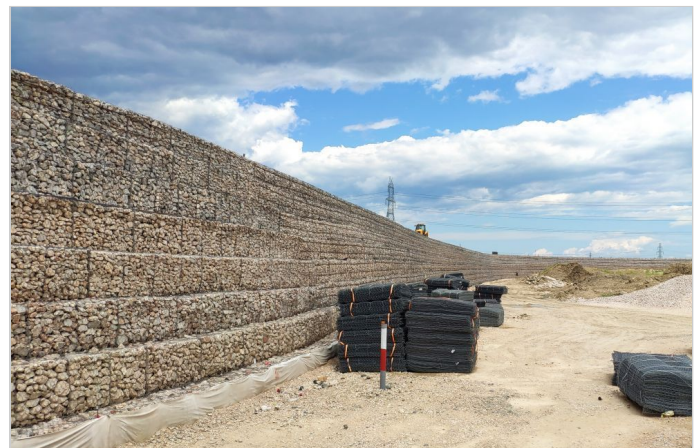
ΚΑΤΑ ΤΗ ΔΙΑΡΚΕΙΑ ΤΗΣ ΤΟΠΟΘΕΤΗΣΗΣ
