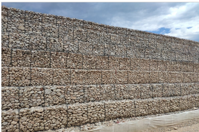
ΚΑΤΑ ΤΗ ΔΙΑΡΚΕΙΑ ΤΗΣ ΤΟΠΟΘΕΤΗΣΗΣ
