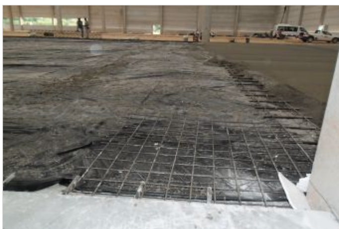
Durante a obra
