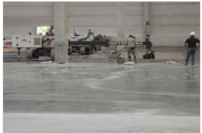
Durante a obra
