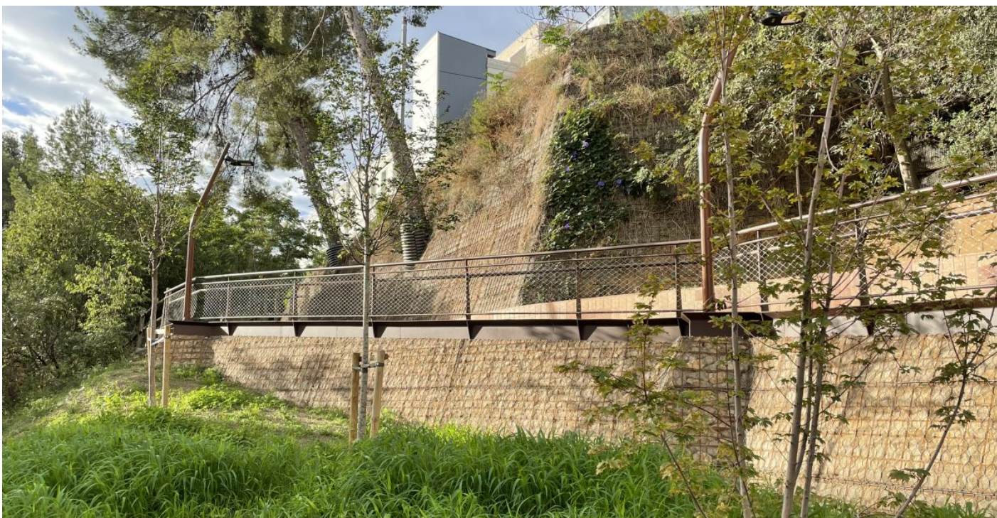
Contrucción de terrazas con el Sistema Terramesh®
