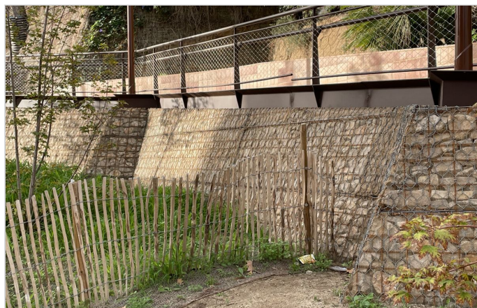
Ejecución de esquinas con el Sistema Terramesh®
