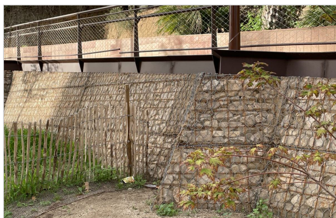
Acabado de esquina con el Sistema Terramesh®
