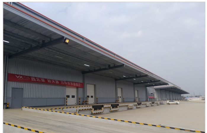
图1 盈石物流(西安)物流园项目
