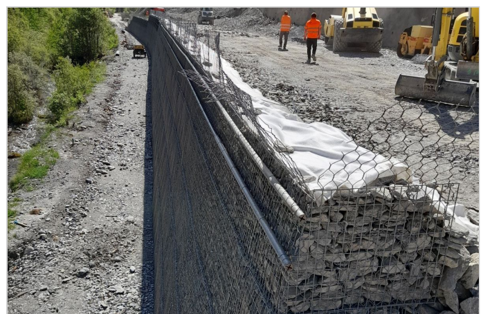
Pendant les travaux
