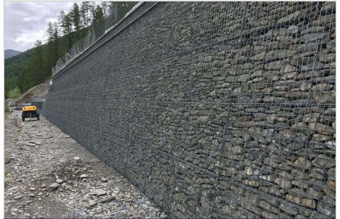
Pendant les travaux
