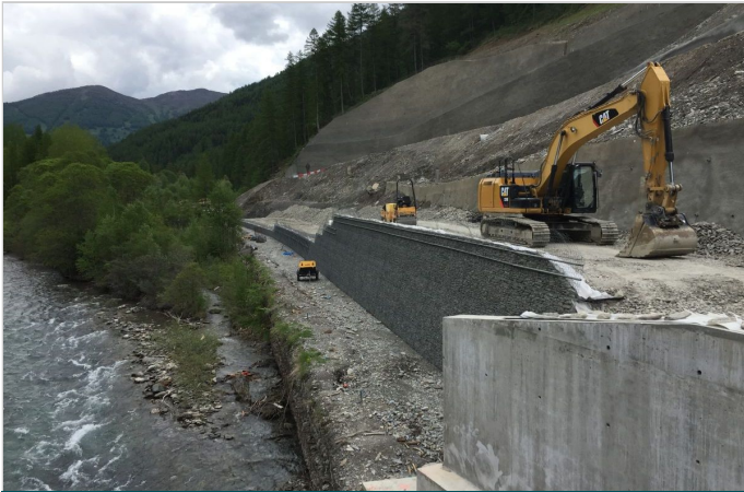
Pendant les travaux
