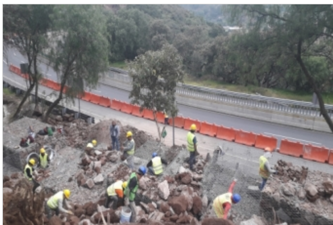
Durante la Obra
