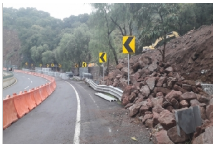
Durante la Obra
