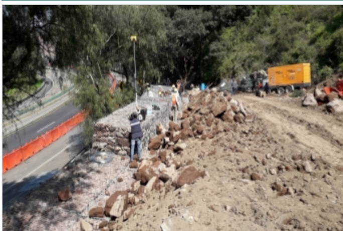
Durante la Obra
