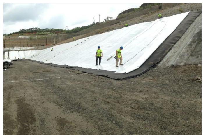
Durante la Obra
