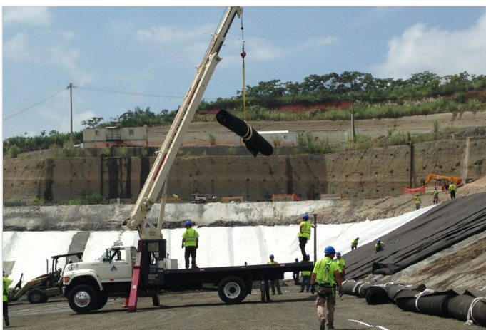
Durante la Obra
