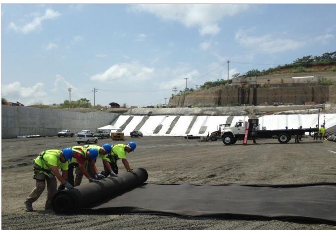
Durante la Obra
