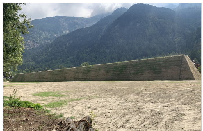
Rilevato paramassi in Terramesh Verde installato
