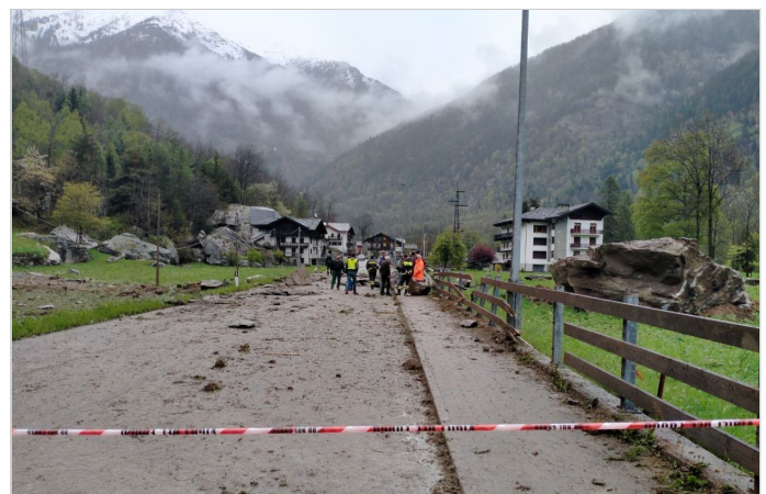
Frana del 6 maggio 2022 (Fonte: Aostanews24)
