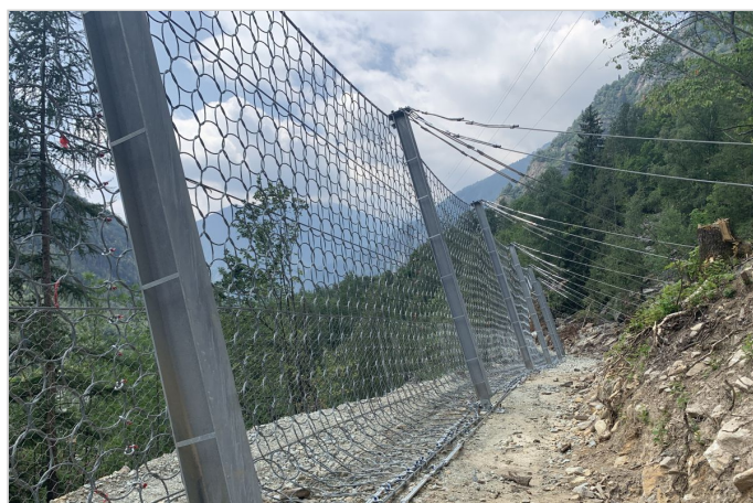
Barriere paramassi RB 9000 installate - vista da monte
