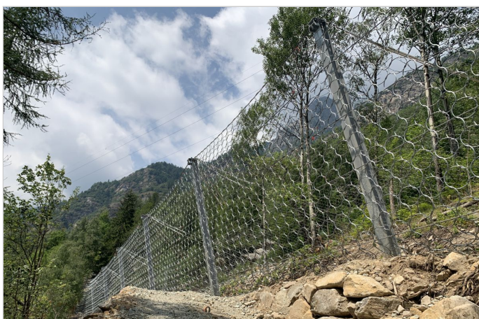
Barriere paramassi RB 9000 installate - vista da valle
