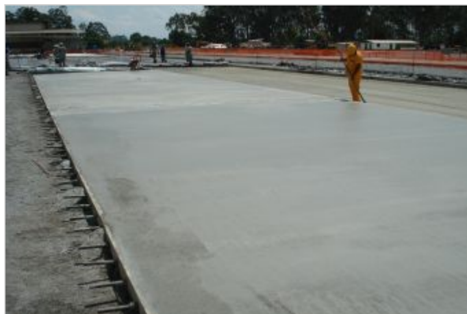
Durante a obra
