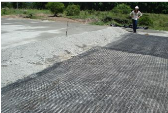
Durante a obra
