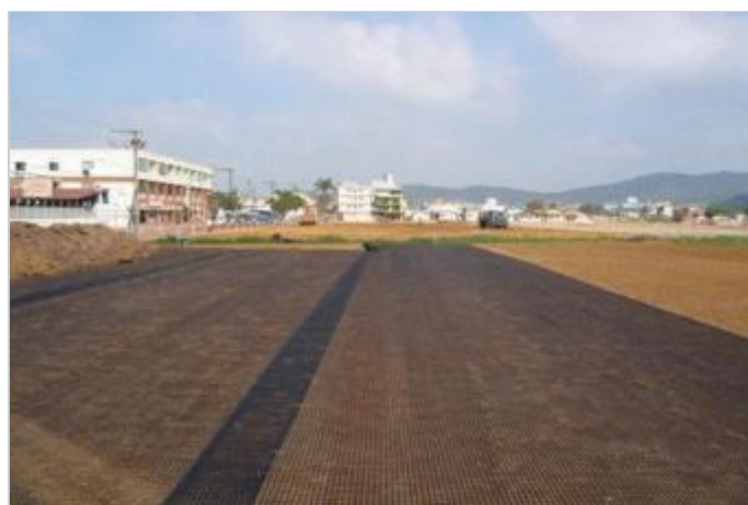
Durante a obra
