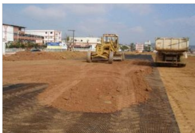
Durante a obra
