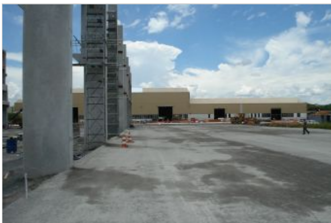
Durante a obra
