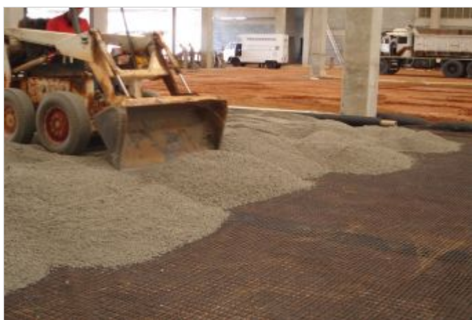
Durante a obra
