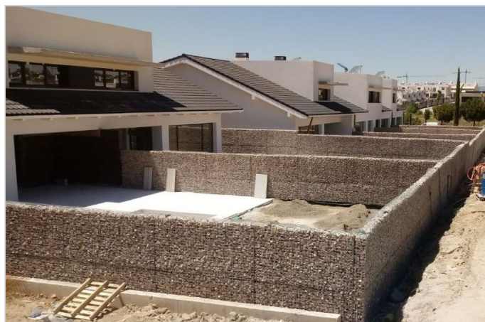
Vista distintos muros (GaviarQ)
