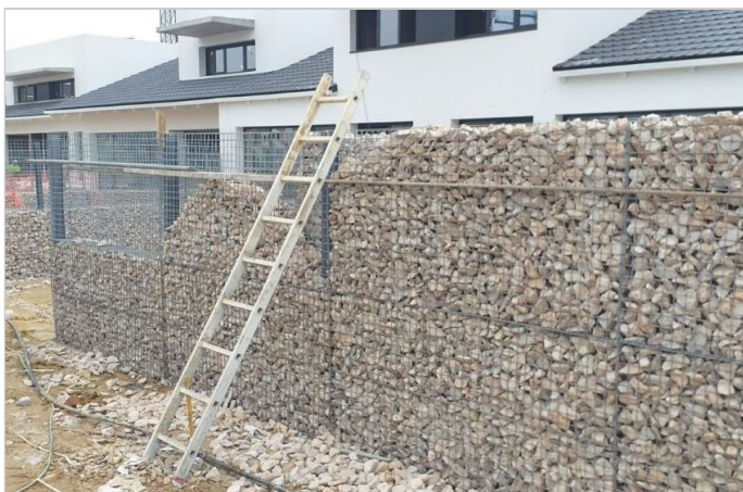
Detalle del proceso de relleno del muro
