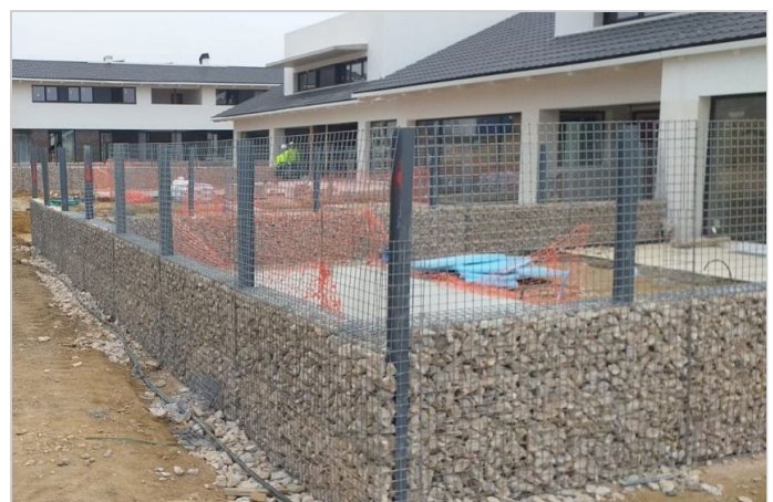
Relleno de la mitad del muro
