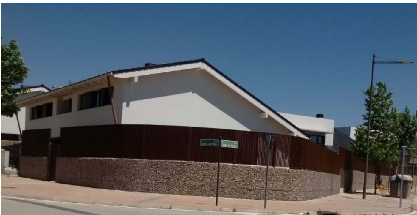
Muro exterior acabado
