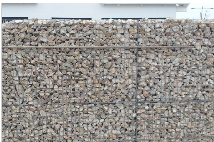
Detalle del careo en el muro
