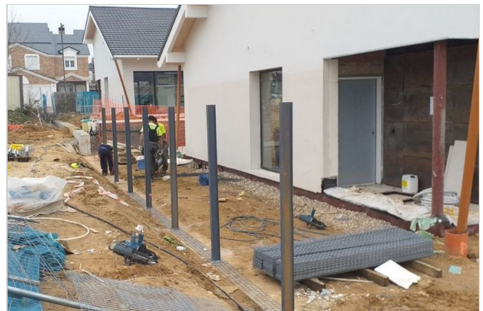
Inicio del montaje de los muros
