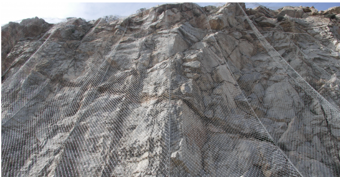
τοποθετημένο STEELGRID MO 300
