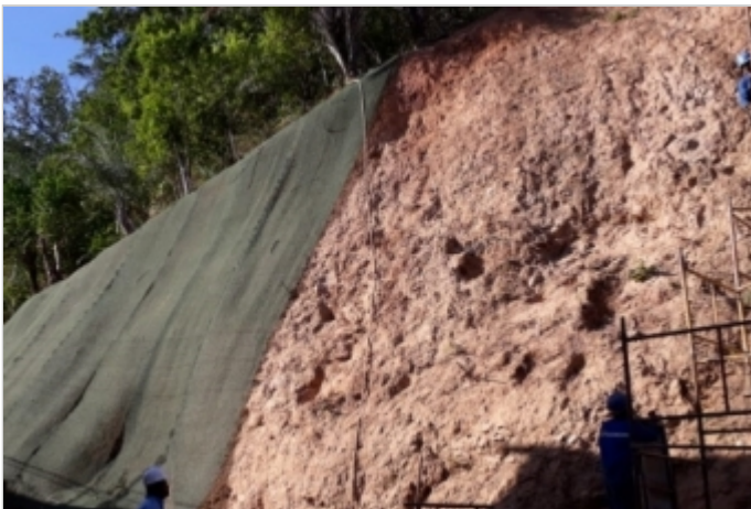
Durante la Obra
