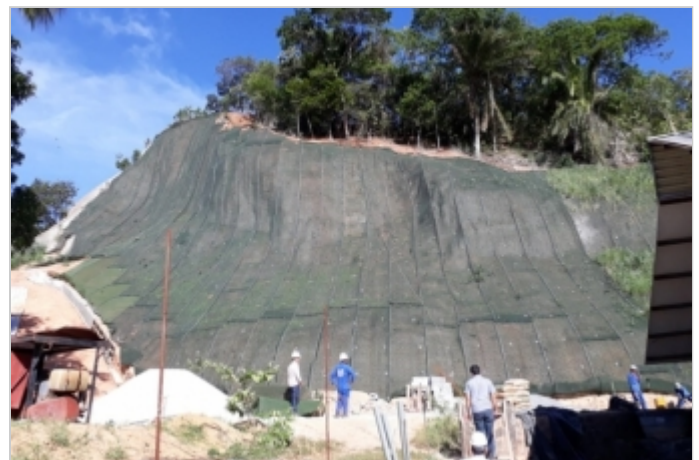
Durante la Obra
