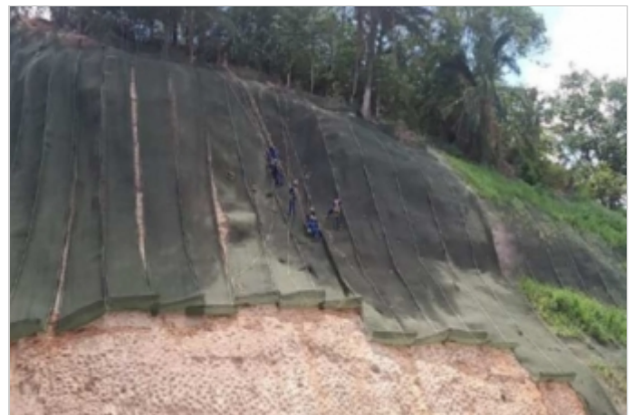
Durante la Obra
