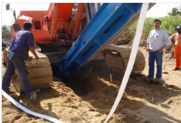
Durante la Obra
