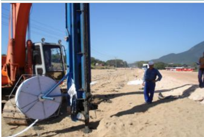
Durante la Obra
