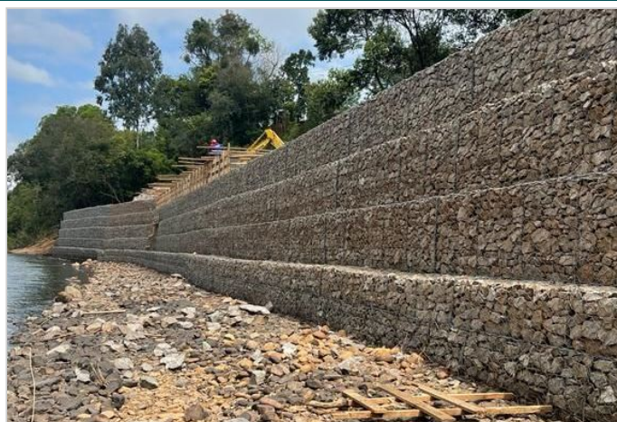
Durante a obra
