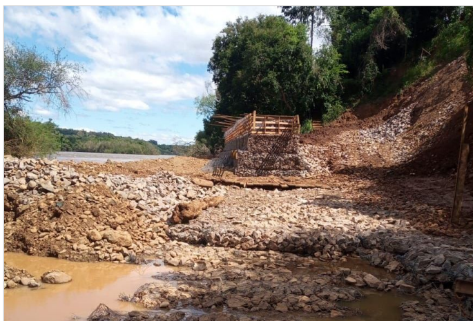
Durante a obra
