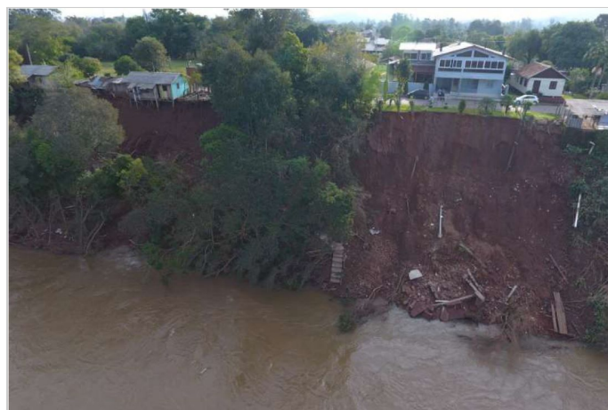
Antes da Obra
