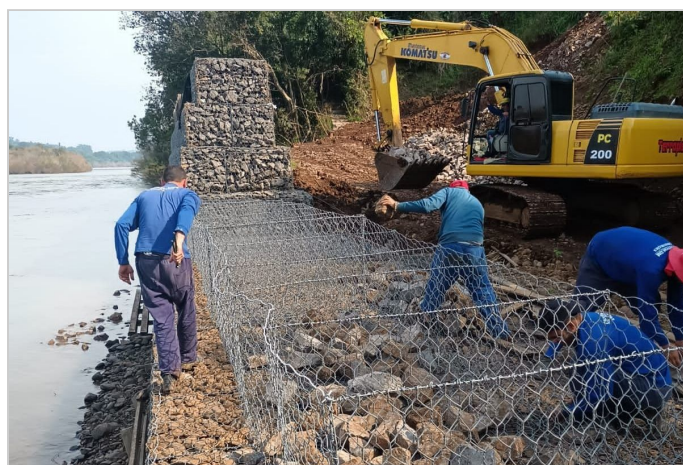
Durante a obra
