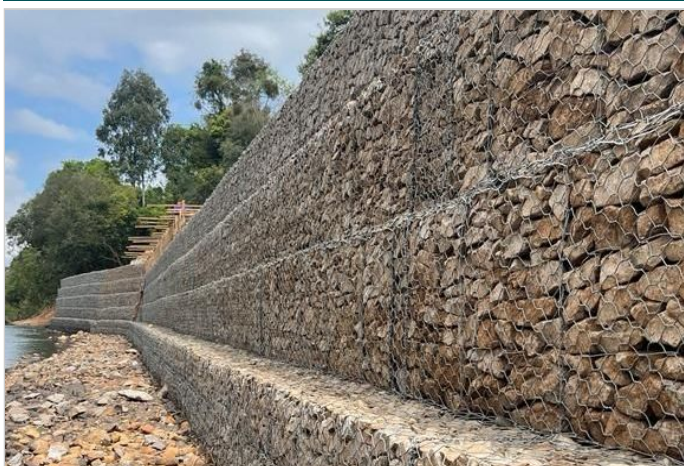
Durante a obra
