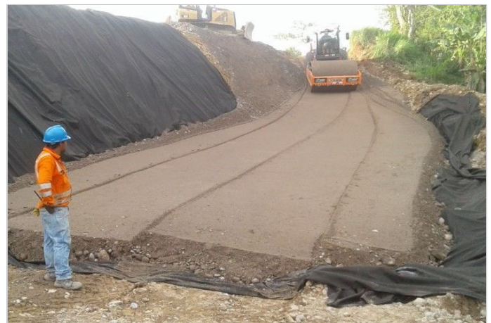
Durante la Obra
