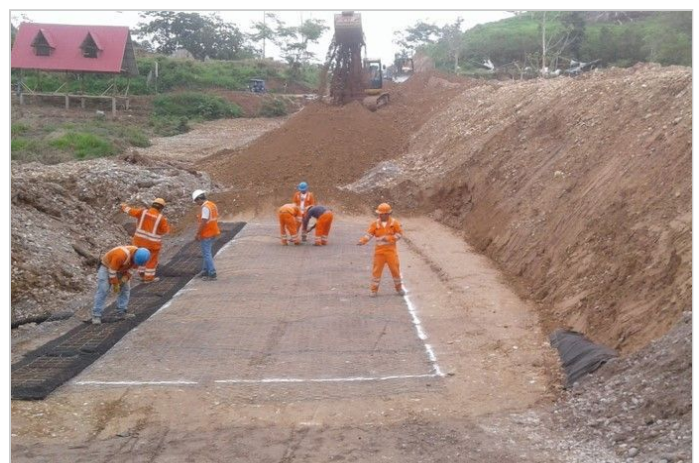
Durante la Obra
