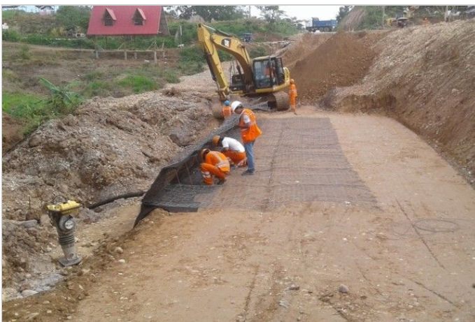
Durante la Obra
