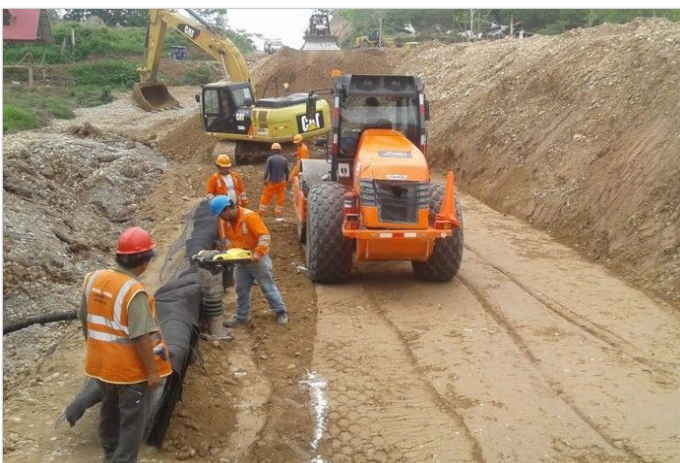
Durante la Obra
