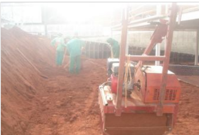
Durante a obra
