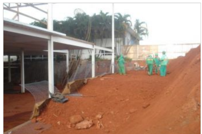
Durante a obra
