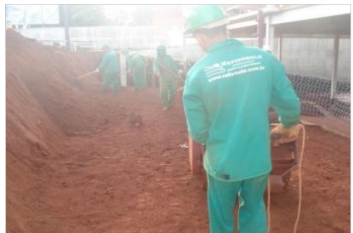
Durante a obra
