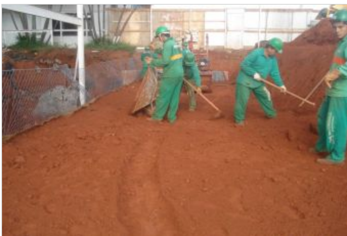
Durante a obra
