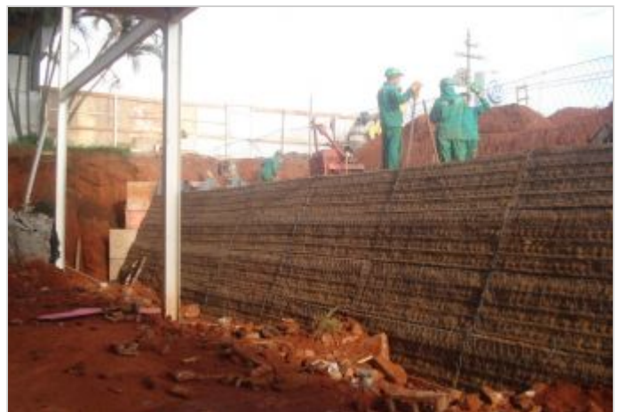
Durante a obra
