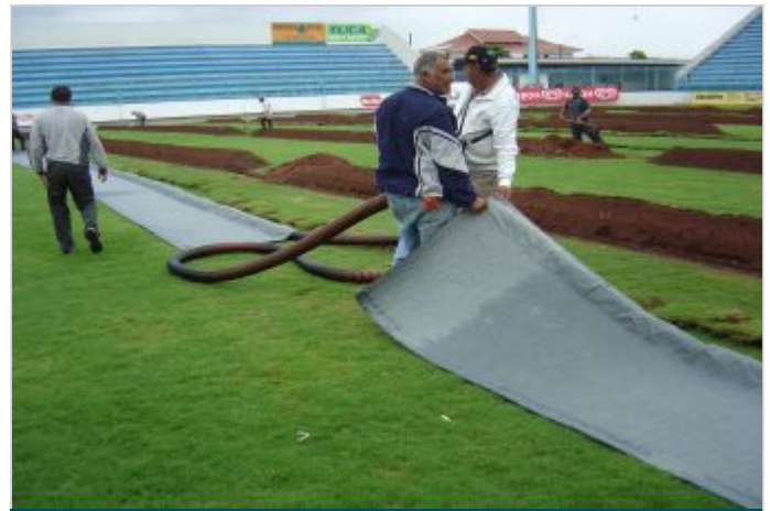
Durante la Obra
