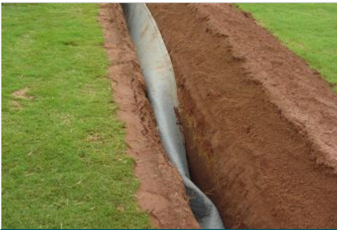
Durante la Obra
