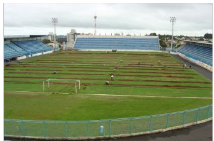
Durante la Obra
