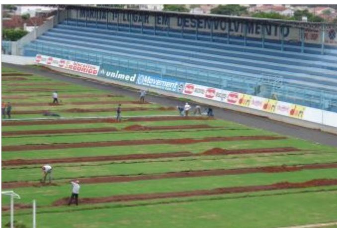
Durante la Obra
