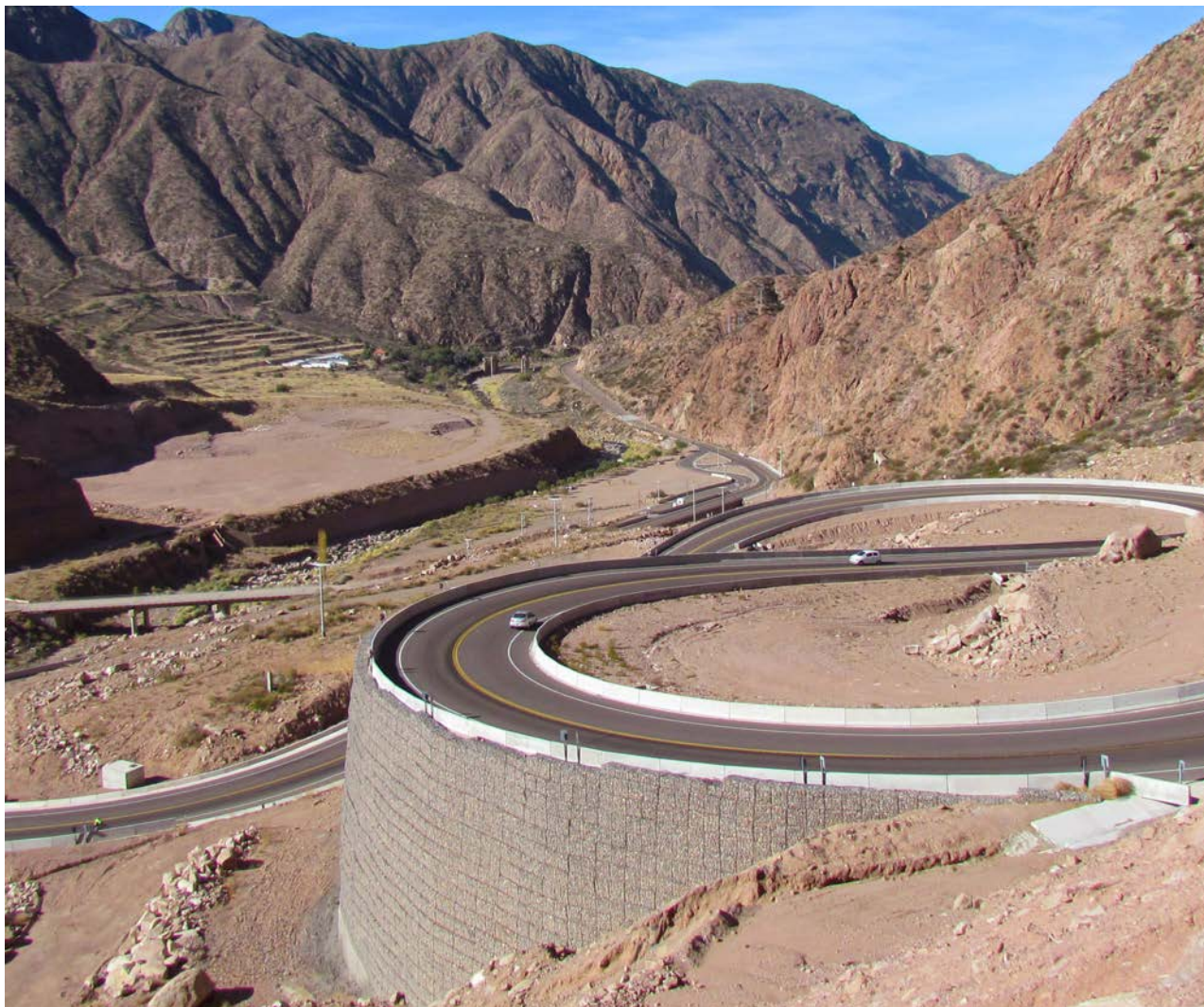
Λύσεις με Τοίχους Συγκράτησης & Οπλισμό Εδαφών
